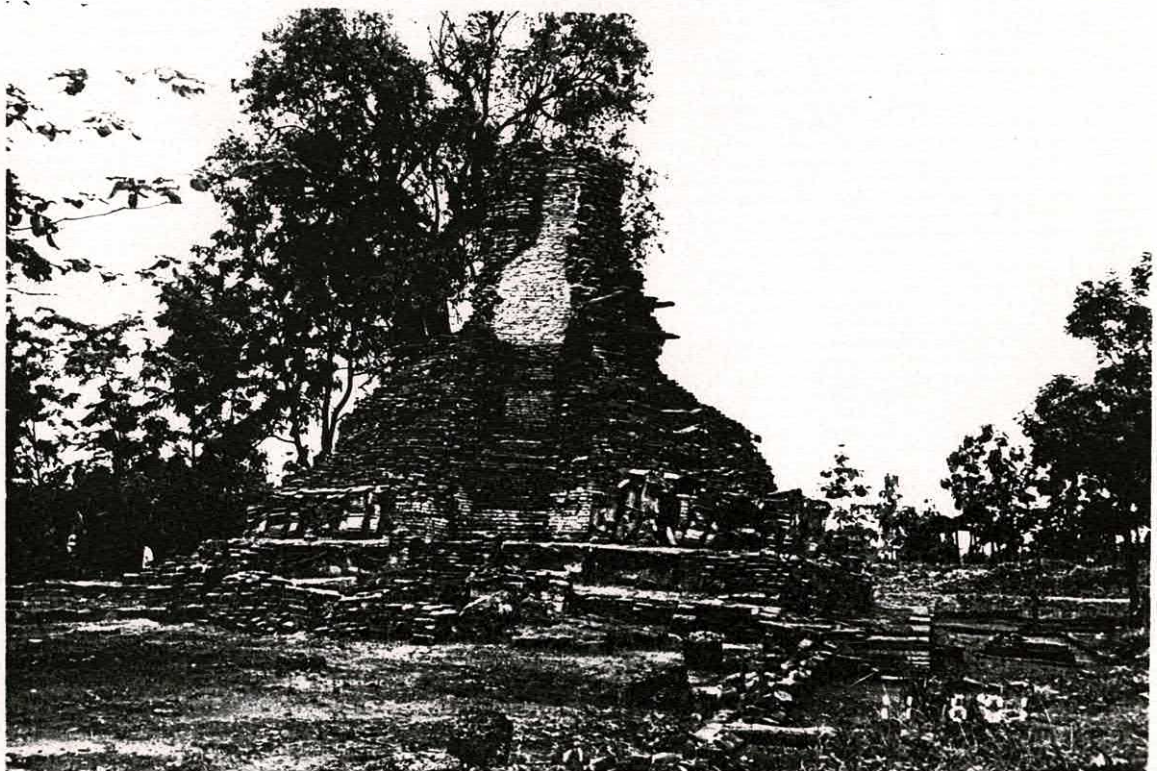
เจดีย์ประธานภายหลังการเสริมความมั่นคง และถอดโครงสร้างค้ำยันออกเรียบร้อยแล้ว
